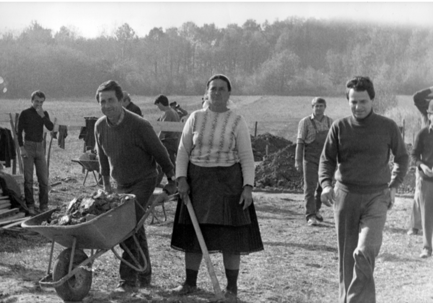
Početak radova na gradnji župne kuće 1973. godine
