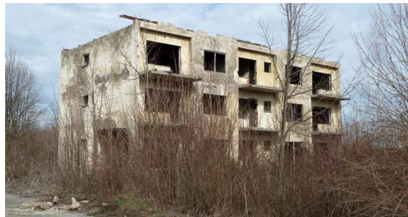
Teško oštećena zgrada sa stanovima za nastavnike
