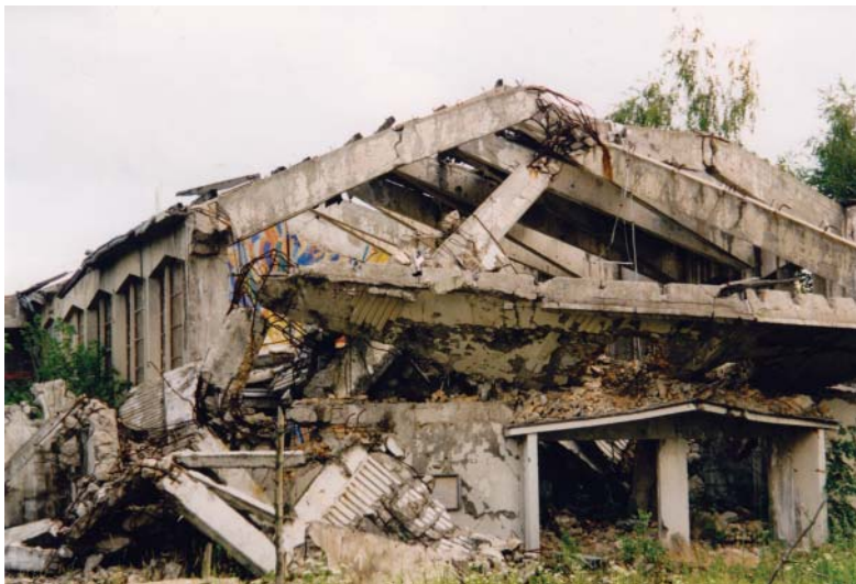
Oštećena župna crkva
