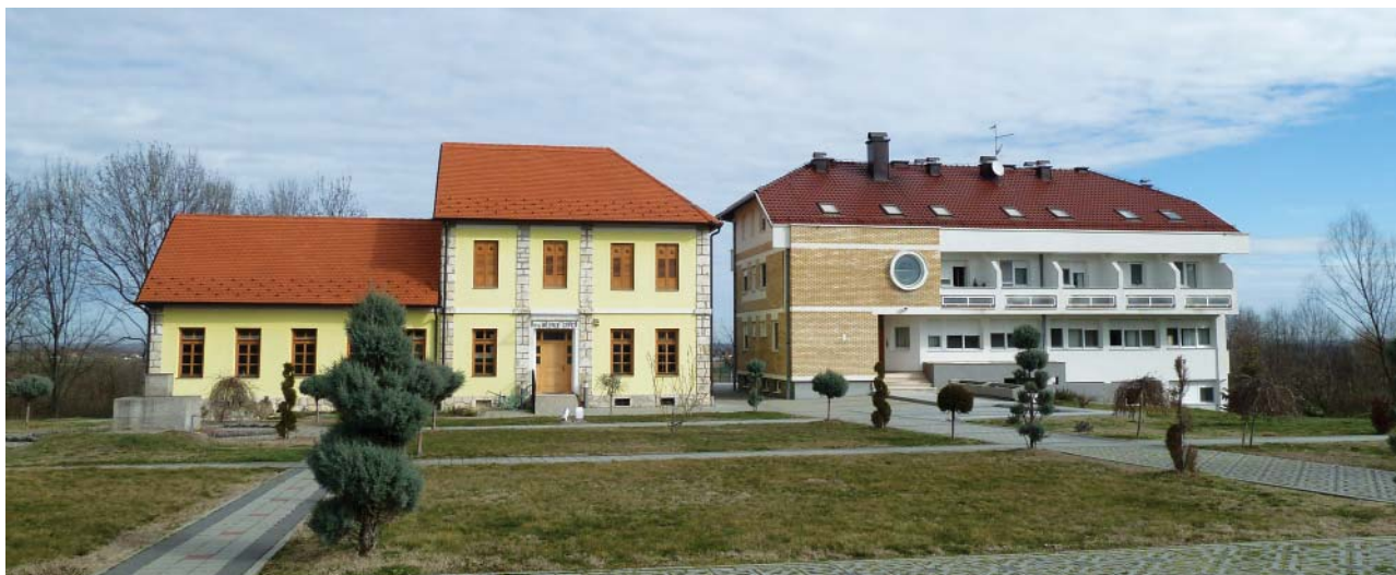
Obnovljeni stari župni stan, sada zgrada muzeja, (lijevo) i samostan sestara franjevki u Gornjoj Tramošnici
